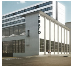
Trafo II, Baden
